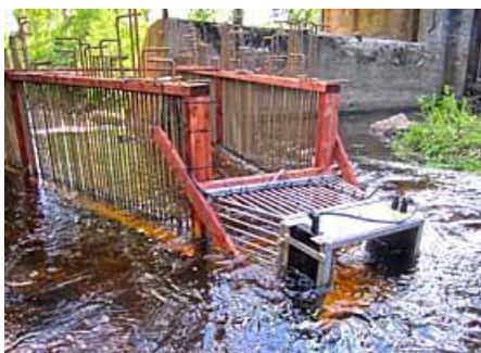
VAKI-räknare installerad vid en fiskväg. Den röda stålkonstruktionen hör inte till själva räknaren utan utgör platsbyggda ledarmar. Foto: Fiskevårdsteknik AB
